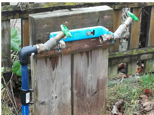
Bauwasseranschlüsse der Stadtwerke Geesthacht
