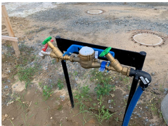
Beispiele Bauwasserversorgung der Stadtwerke Geesthacht
